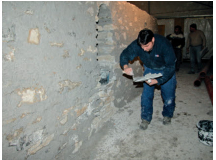
Les participants vont passer au côté pratique avec la construction dans une halle des murs de moellons liés à la chaux.
